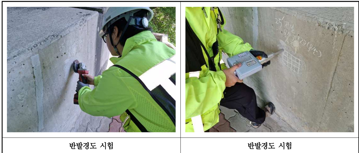
【사진 32.4.2】 반발경도시험 현장사진
