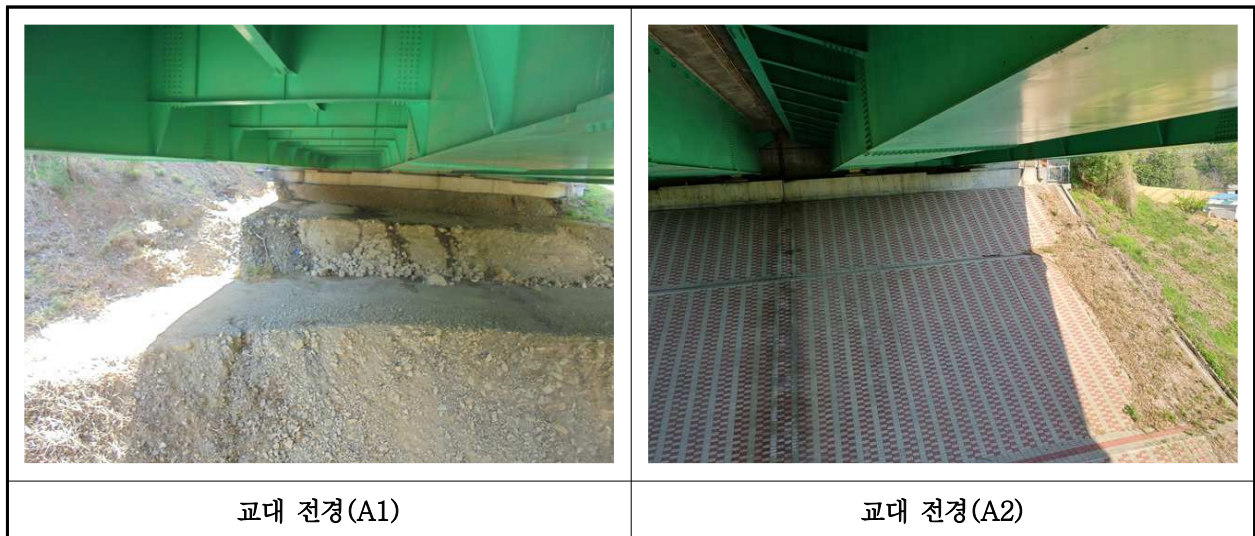
【사진 32.3.8】 교대 전경
