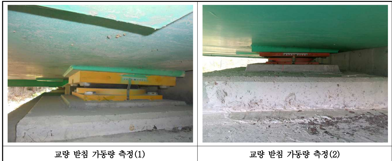
【사진 32.3.16】 교량받침 이동량 측정
