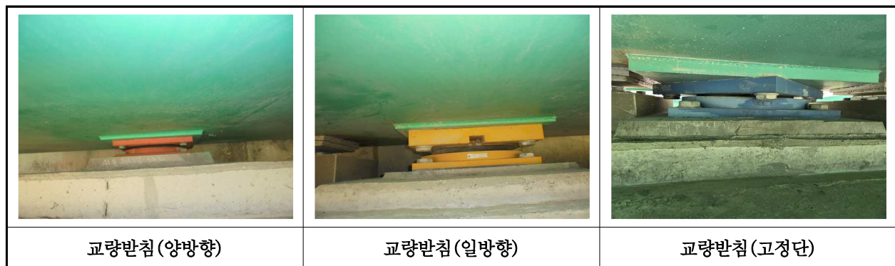
【사진 32.3.13】 교량받침 전경
