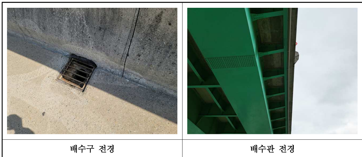
【사진 32.3.22】 배수시설 전경
