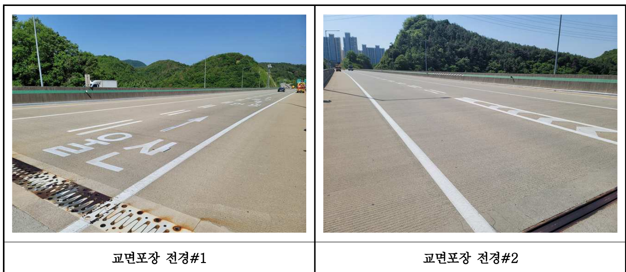
【사진 32.3.20】 교면포장 전경
