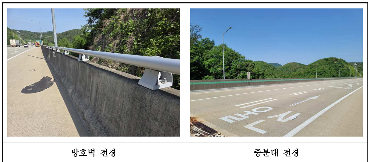
【사진 32.3.24】 방호벽 및 중분대 전경
