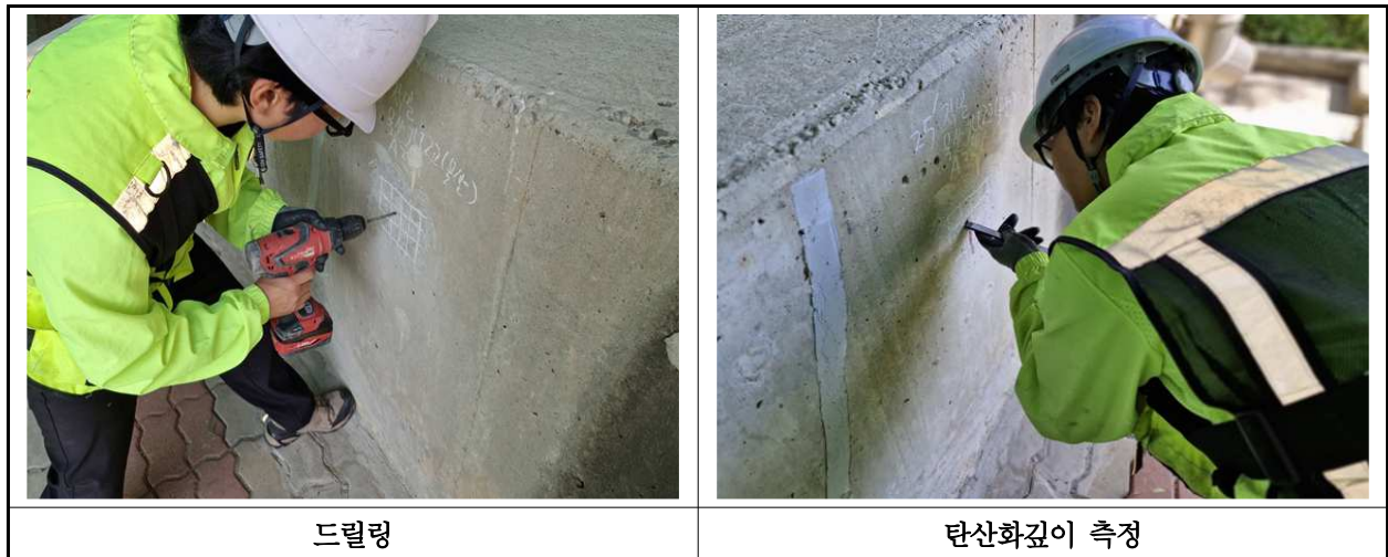
【사진 32.4.3】 탄산화 깊이 측정 현장사진
