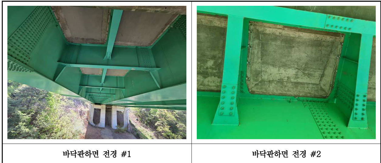
【사진 32.3.2】 바닥판하면 전경
